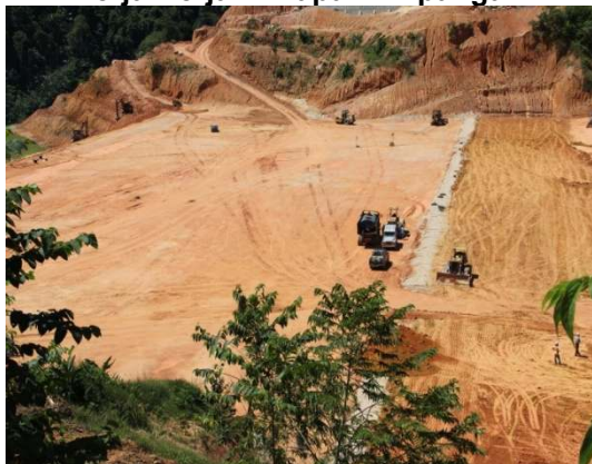
Gambar 4.5 Kerja-Kerja Di Tapak Empangan
