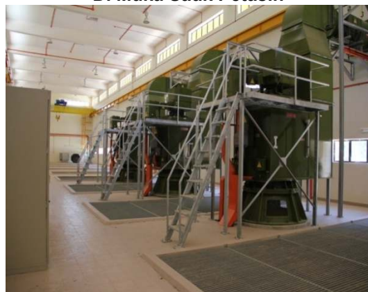
Gambar 4.4 Mesin Pengepam Air Mentah Di Muka Sauk Petasih
