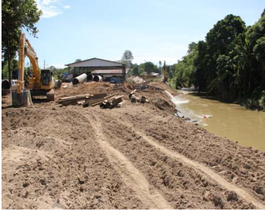
Gambar 4.1 Pemasangan Paip Laluan 2B Di Tepi Sungai
